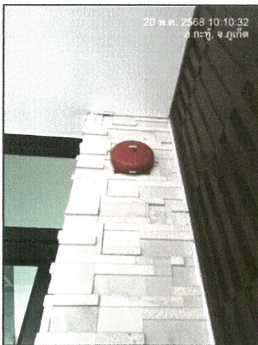
กริ่งสัญญาณเตือนภัย
