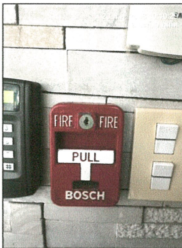
อุปกรณ์แจ้งเหตุเพลิงไหม้ด้วยมือ
